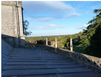
N aisle roof
